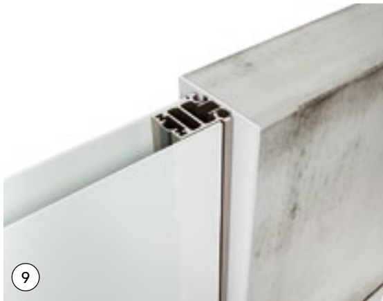
Сопряжение фрамуги и стены Interface of transom light and wall
